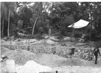
▲ 건축 중인 La Bruyere학교의 공사현장으로 올해 8월말 완공예정이다.
